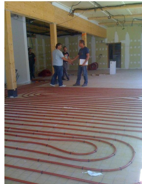
**DANS LA SALLE À MANGER LE PAREMENT DES MURS EST PRÉPARÉ ET LE PLANCHER CHAUFFANT EST INSTALLÉ.**
