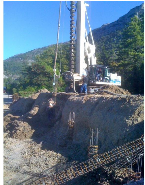
**X PIEUX DE X À MÈTRES DE PROFONDEUR À TRAVERS LA MARNE POUR ATTEINDRE LA ROCHE DURE.**
