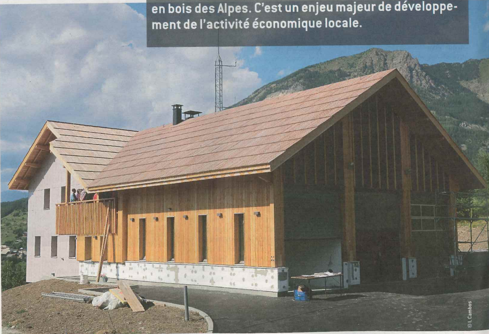
Le bâtiment est composé de 250 m2 de bardage et 450 m2 de bardeau en bois de mélèze des Hautes-Alpes
